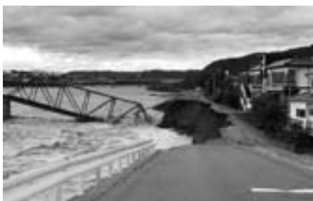
上田市諏訪形 堤防欠損、 上田電鉄別所線鉄橋崩落現場
