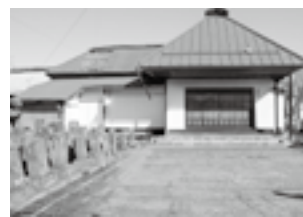
県道側正面景観
